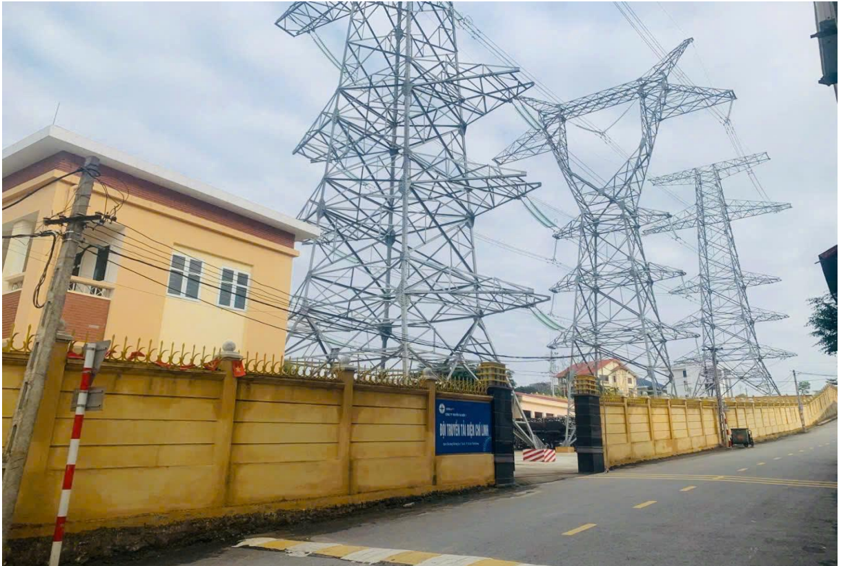
Hiện trường đào tạo thực hành cho công nhân Quản lý vận hành và sửa chữa đường dây
