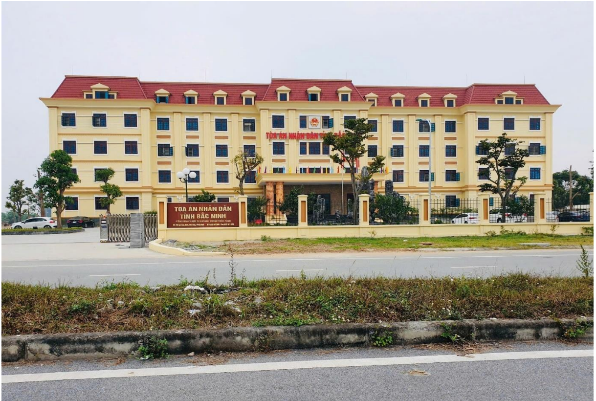
Trụ sở làm việc Tòa án nhân dân tỉnh Bắc Ninh
