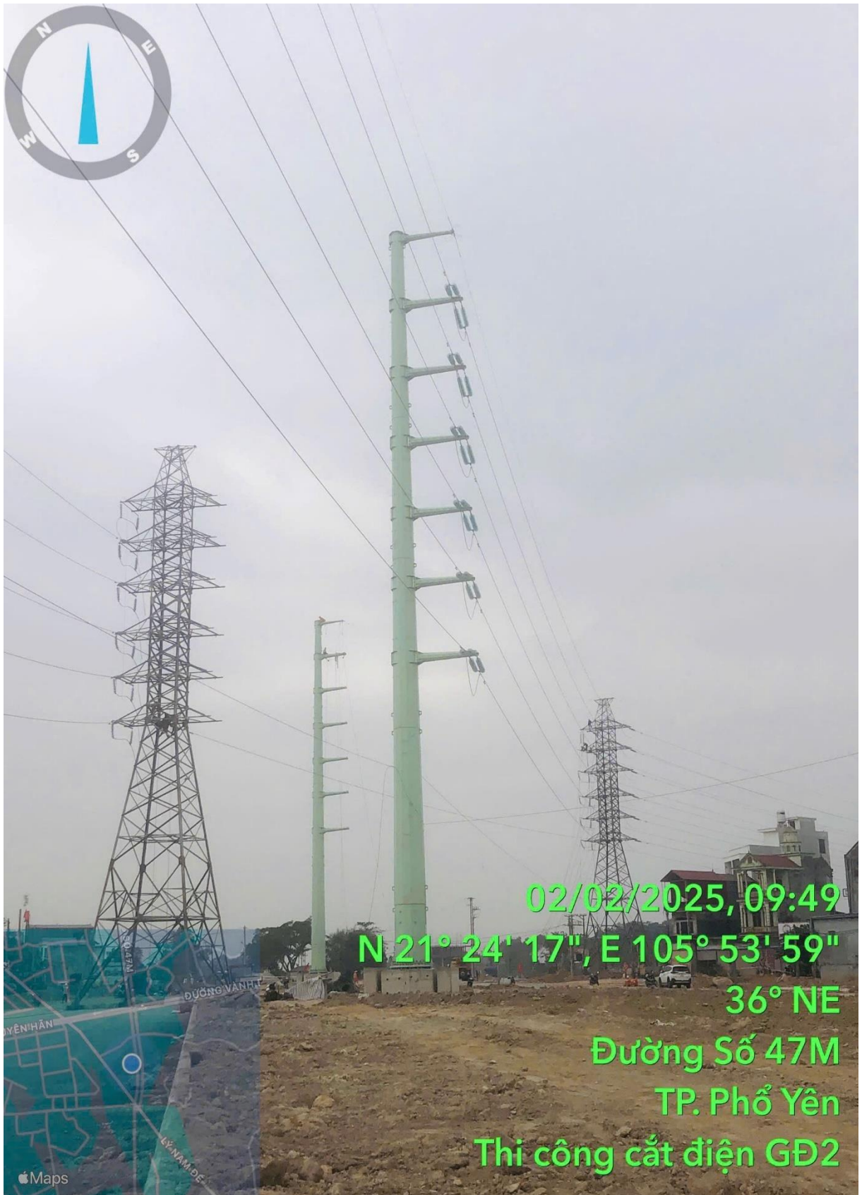
Di chuyển tuyến điện 110kv - Tuyến đường liên kết nối các tỉnh Thái Nguyên, Bắc Giang - Thi công cắt điện GD 2
