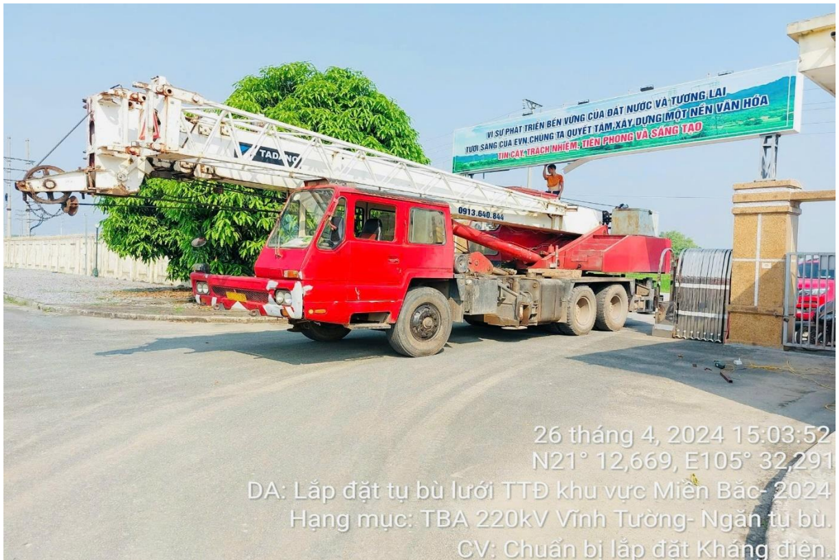
TBA 220 kv Vĩnh Tường – Chuẩn bị lắp đặt kháng điện
