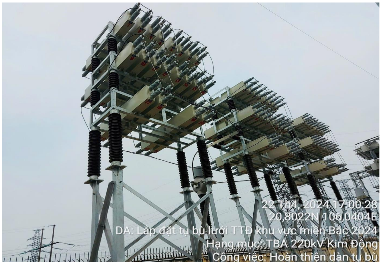
TBA 220kv Kim Động – Hoàn thiện dàn tủ bù
