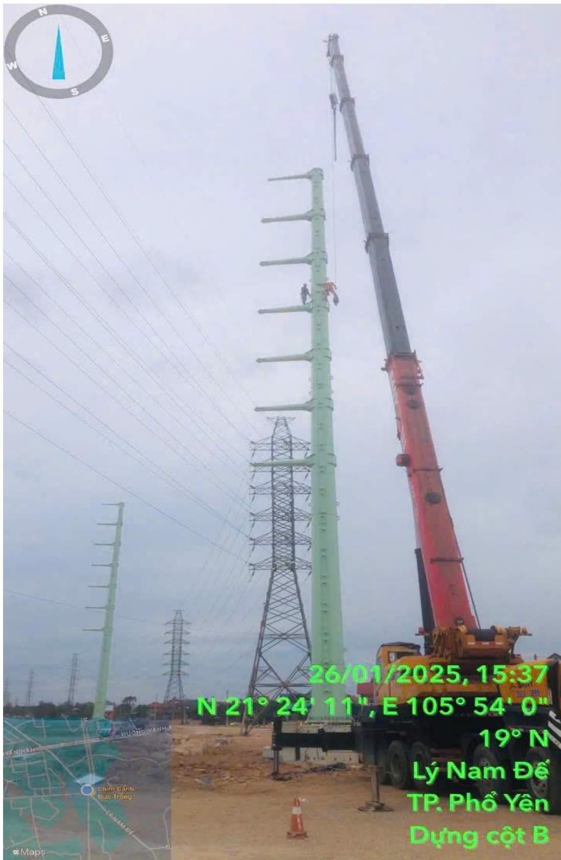
Di chuyển tuyến điện 110kv - Tuyến đường liên kết nối các tỉnh Thái Nguyên, Bắc Giang - Lắp dựng cột đơn thân B
