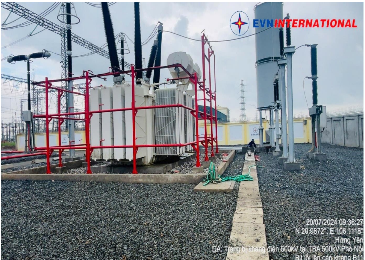
TBA 500 kv Phố Nối – Lắp đặt kháng tự
