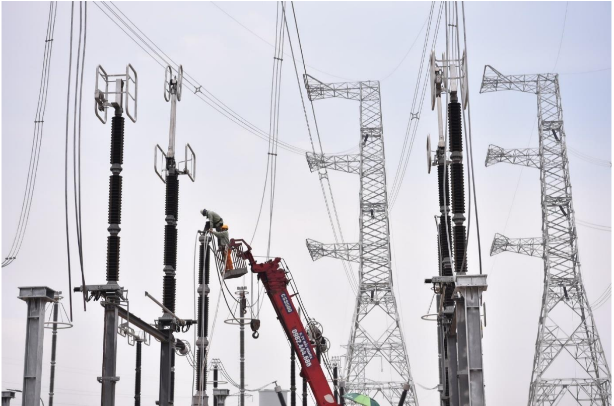
Thi công TBA 500kv Phố Nối
