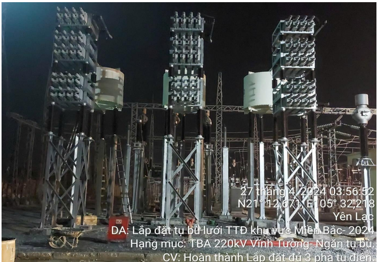
TBA 220 kv Vĩnh Tường - hoàn thành lắp đặt đủ 3 pha tủ điện
